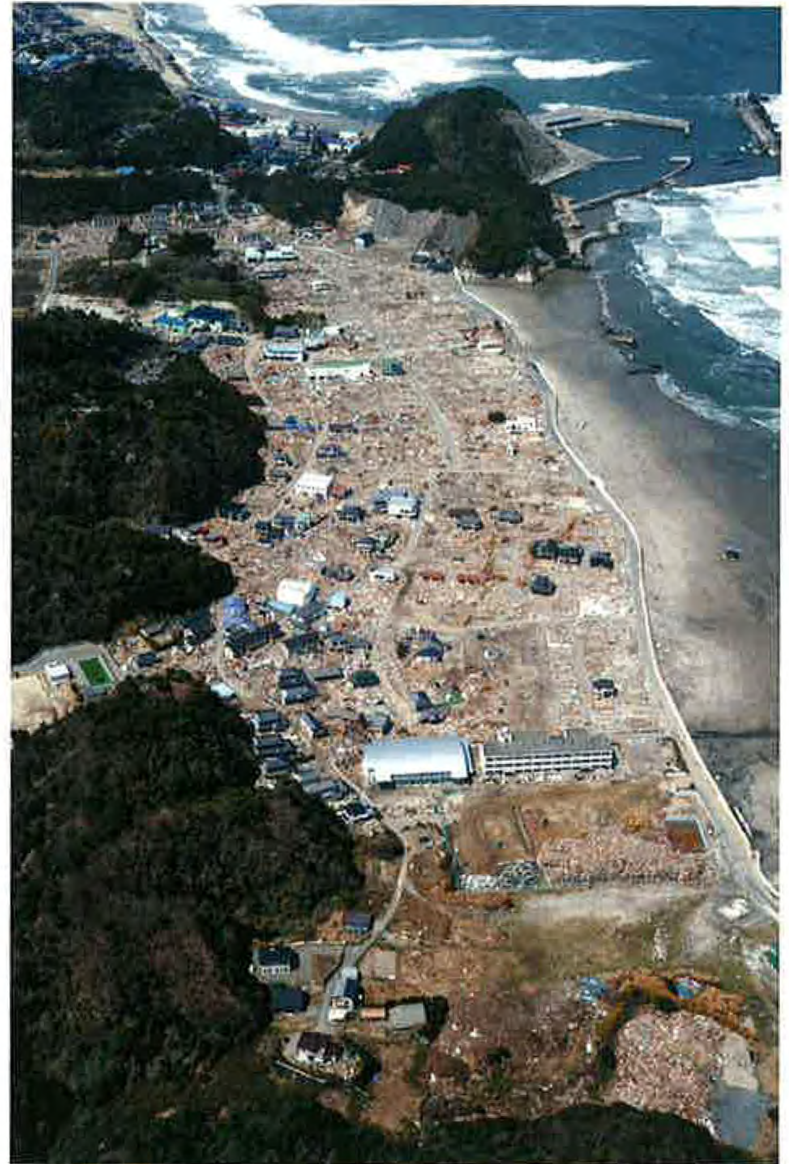
津波で多くの家屋が流された平薄磯地区 *1 (平成23年4月21日)
