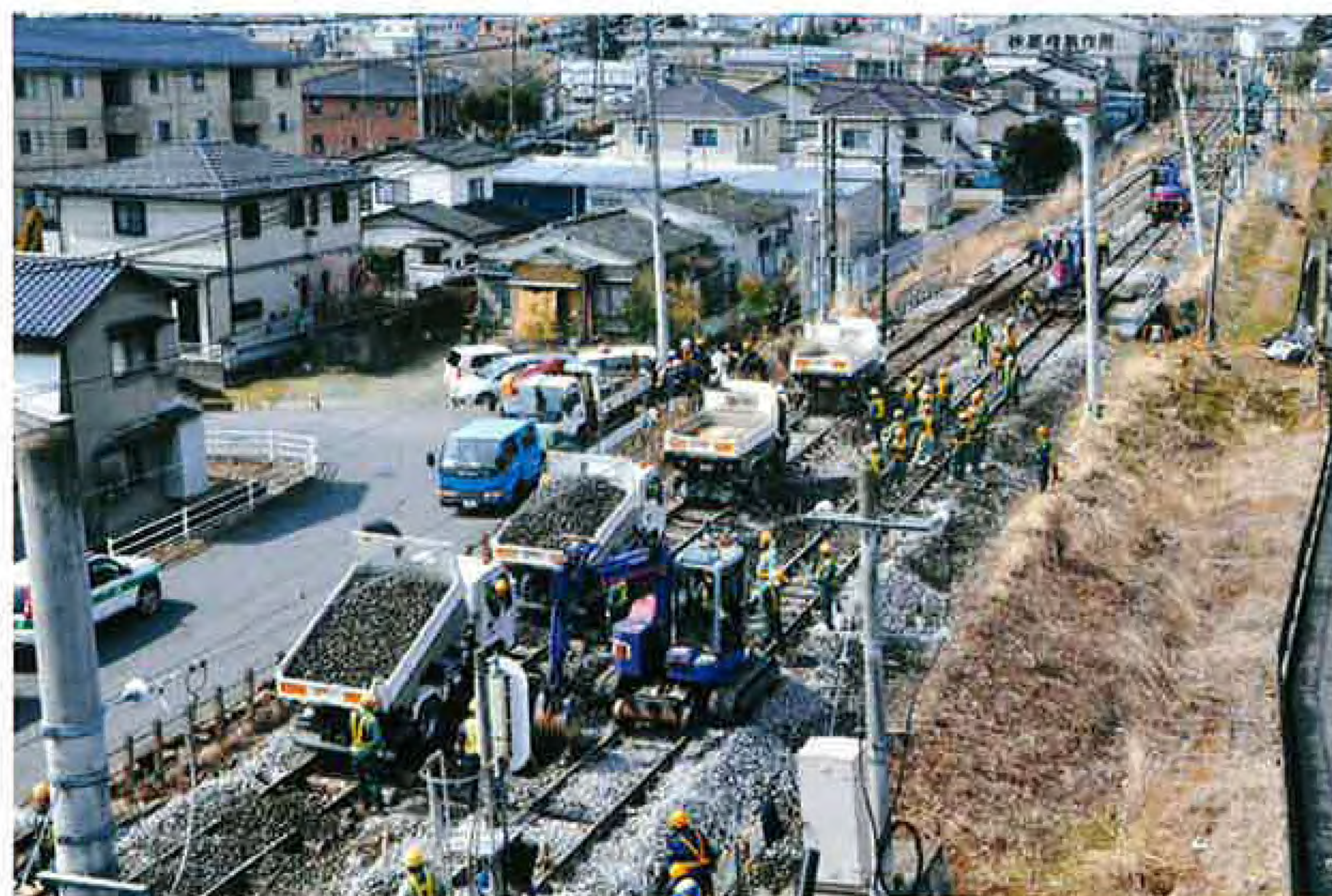
急ピッチで復旧工事が進むJR常磐線 *1 (平成23年3月31日)
