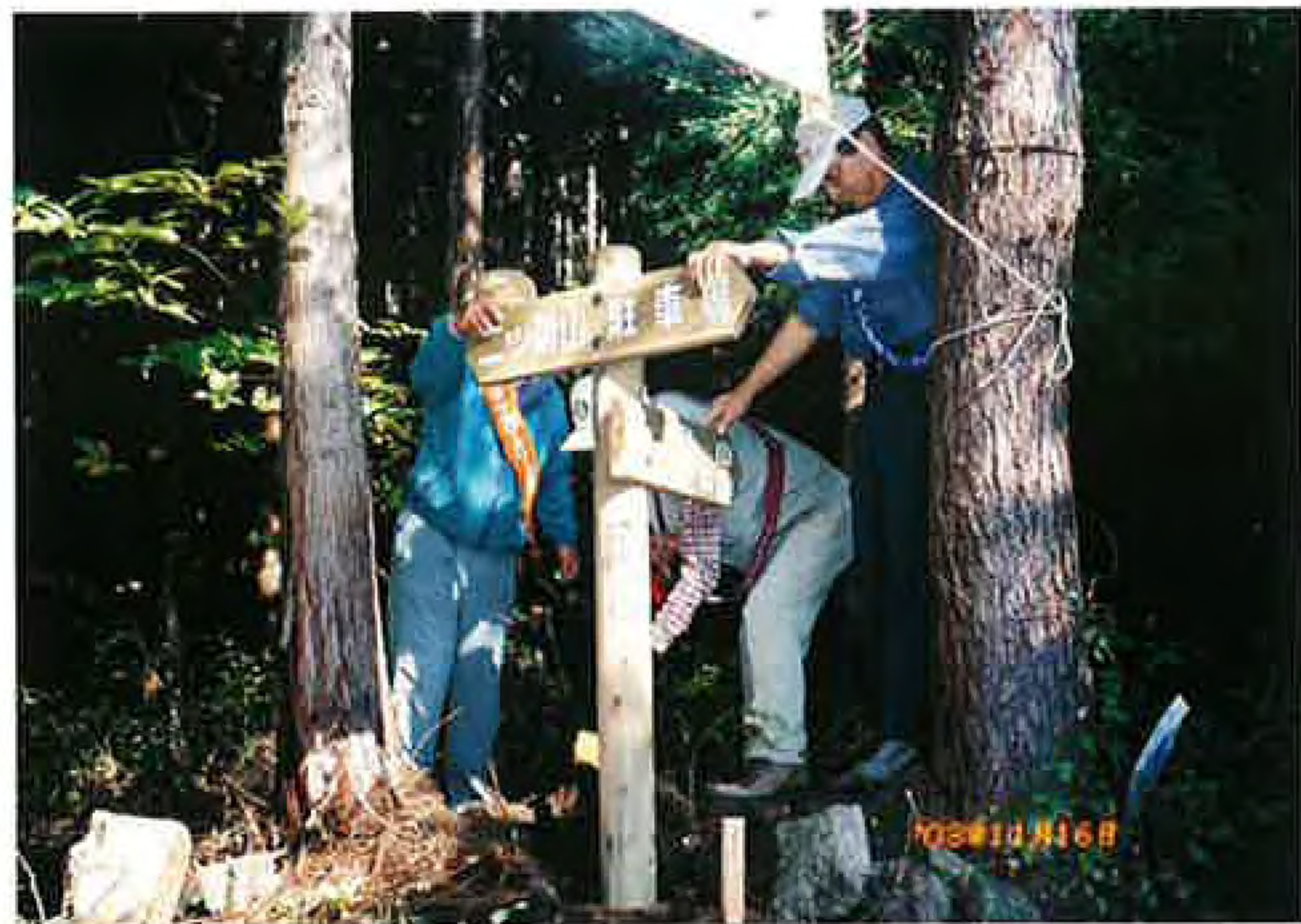
二ツ箭山へ道標の設置
