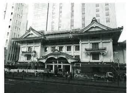
建設が急ピッチで進む東京・銀座の新歌舞伎座。上階は高層のオフィスビル
